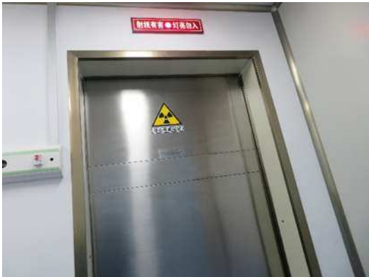
图 3-4 病人出入机房防护门
